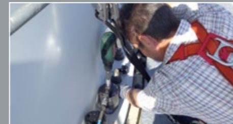
Ankerbolzenmontage mit Schraubenspannvorrichtungen Anchor bolt assembly with bolt tensioners
