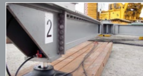
Anheben und Nivellieren schwerer Lasten mit Hochdruck Hydraulik Lifting and leveling of heavy loads with high-pressure hydraulic
